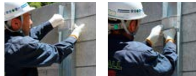
①穴合わせとネジの差し込み ②蝶ナットで締め付け固定
