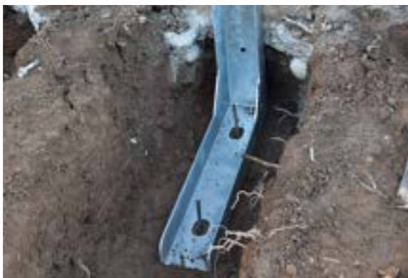
※穴掘り箇所を鉄筋棒などでマークをすると 施工が容易です。
