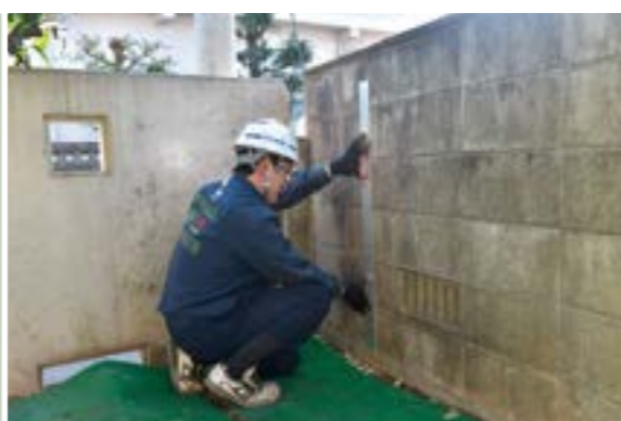
●道路・隣地側プレートと角根丸頭ボルトをセット
