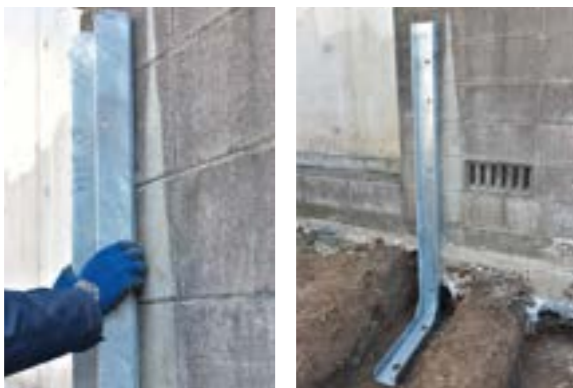
●敷地側アンクル支柱の仮置き
