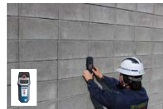
金属探知機(有償貸出しています)による鉄筋調査
