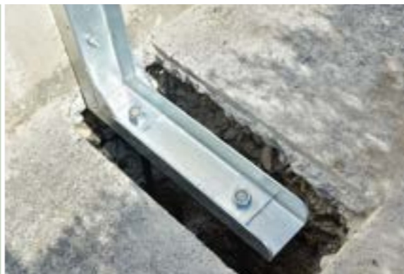
●敷地側アンクル支柱を通して杭基礎坑に ロックボルト(パワースレッド)をセット
