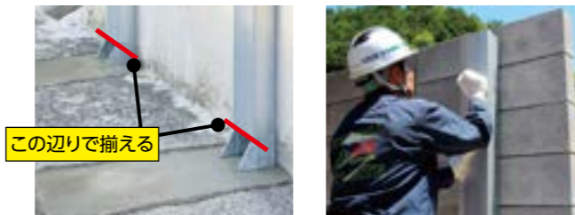
①下辺補強部を目安にセット ②はめ込み
