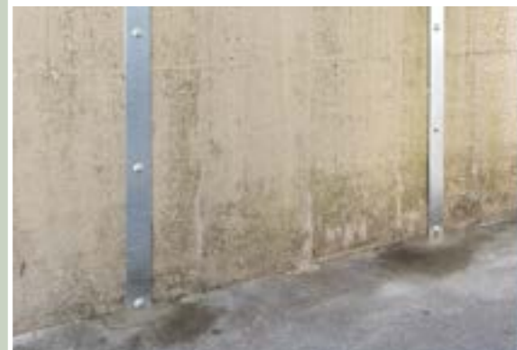
●道路・隣地側完成 写真 FITパワー 18型プレート
