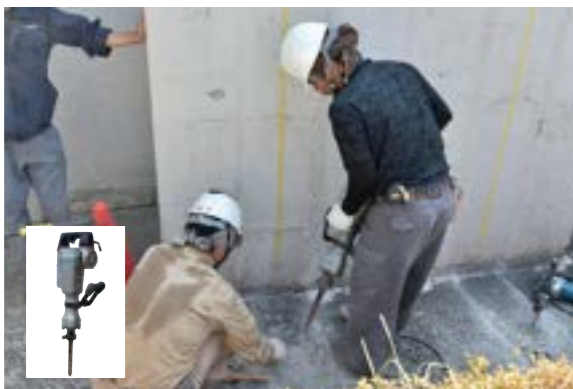
●コンクリート部分のハツリ作業 (既設ブロック塀のベース基礎のハツリ含む)
