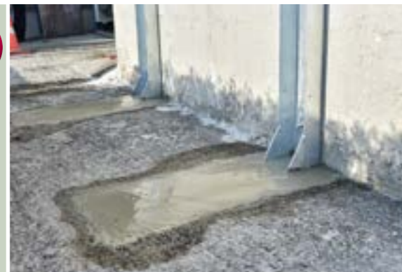
●敷地側完成 写真 FITパワー 18型アンクル支柱
