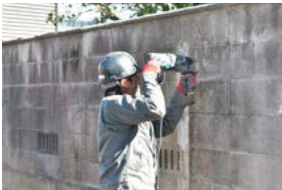
●ボルト取り付け用の貫通穴を開ける (振動ドリル)φ15mm~18mm
